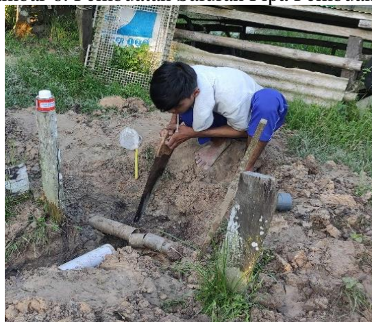
Gambar 6. Pembuatan Saluran Pipa Pembuangan
