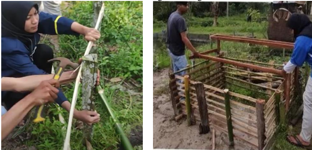
Gambar 5. Pemasangan Kerangka Kolam
