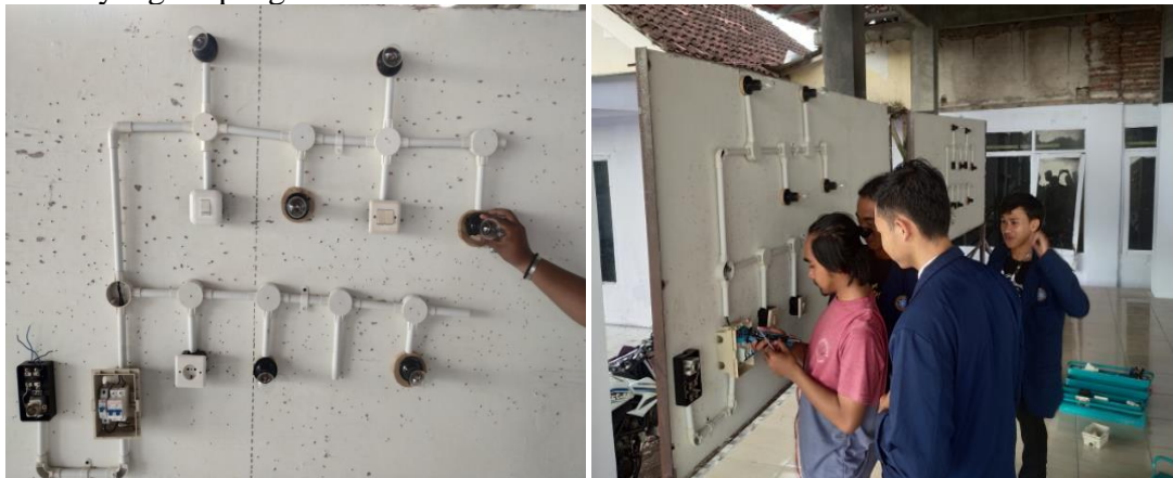
Gambar 4. Proses Pelatihan Instalasi Listrik Hubungan Saklar Tunggal
