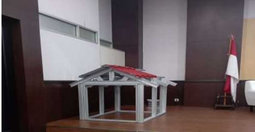
Gambar 4. Maket Konstruksi Atap Rumah dengan Bahan Baja Ringan
